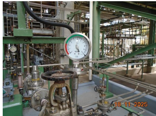
ภาพที่ 2.1-39 เกจวัดอัตราการไหล ความดันและ เทอร์มิสเตอร์ ที่ท่อขนส่งต้นทาง
