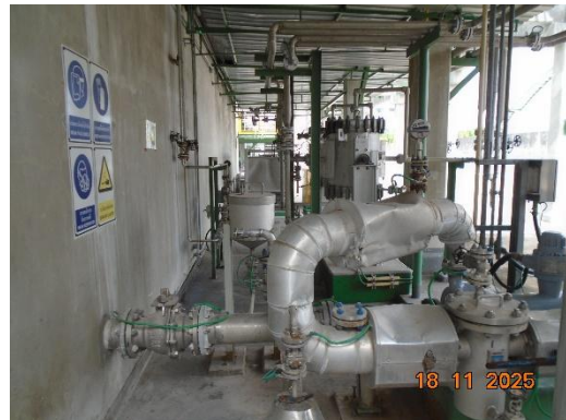
ภาพที่ 2.1-29 ระบบการควบคุมอุณหภูมิในถังเก็บกัก MAA (การติดตั้ง Chiller, Circulation Pump)
