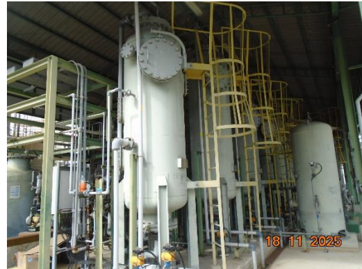
ภาพที่ 2.1-54 ระบบ RO unit
