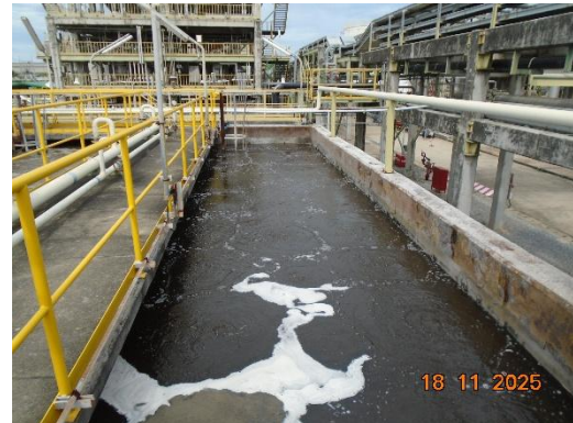
บ่อ Equalization โรงงาน 2
