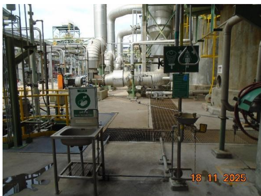
ภาพที่ 2.1-44 ฝักบัวฉุกเฉินและอ่างล้างตาฉุกเฉิน
