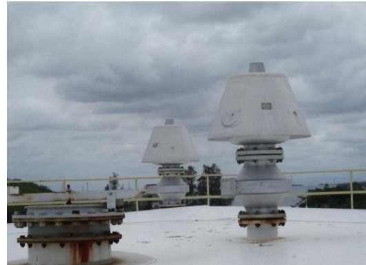
ภาพที่ 2.1-35 Safety Valve บริเวณถังเก็บกัก
