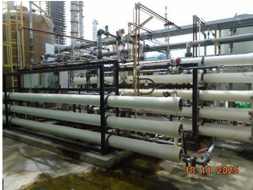
ภาพที่ 2.1-54 ระบบ RO unit
