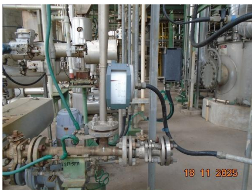
ภาพที่ 2.1-32 ระบบการตรวจวัดอัตราการไหลของวัตถุดิบ
